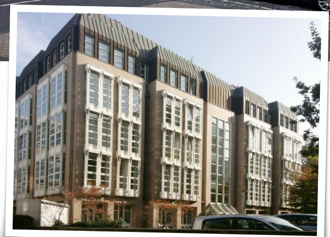
Der WDR-Bau vor der Kernsaniierung
