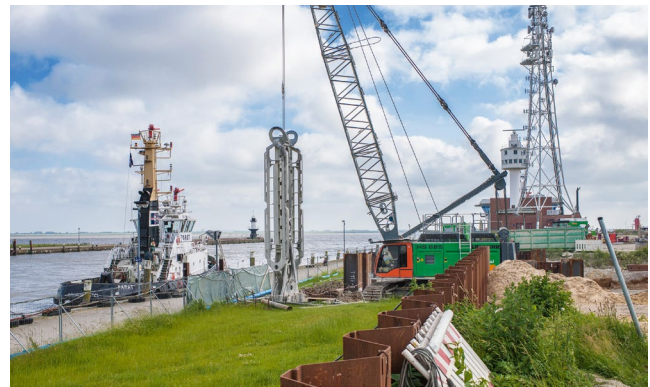
Auf der aktuell größten Wasserbaustelle Deutschlands kommen „Dichtwandgreifer“ zum Einsatz, z. B. beim Bau von Schlitzwänden.
