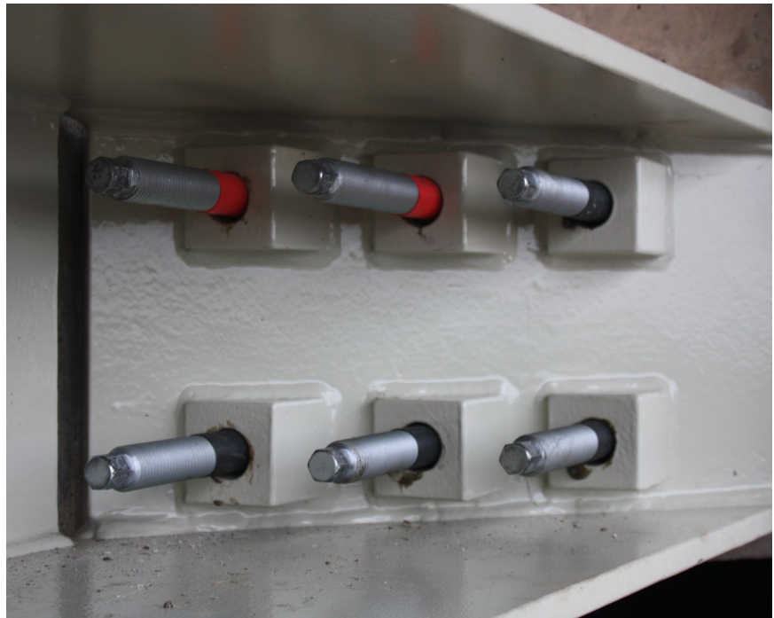
Endverankerung mit Verbundankerschrauben
