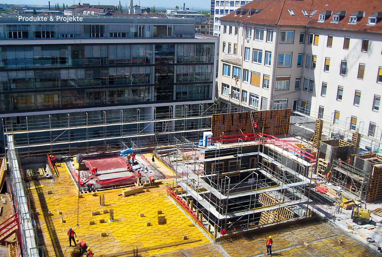
Zwei Strahlenbunker entstehen beim Neubau des Klinikums in Darmstadt.
