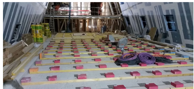
Punktlager aus Sylodyn® und Sylomer® schützen die angrenzenden Räume vor Erschütterungen und Lärm.
