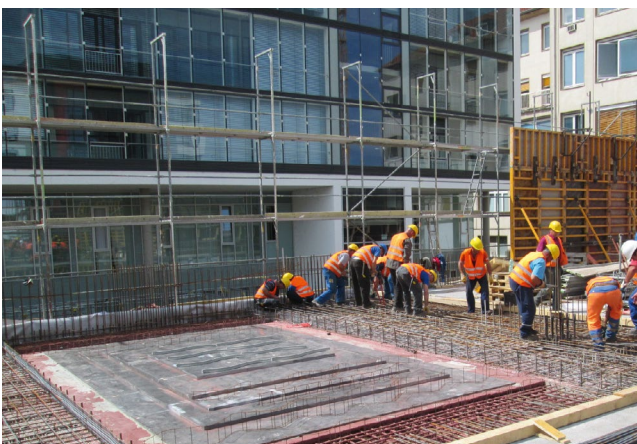
Fünf Lagen bilden die stufenförmige Bleieinlage.
