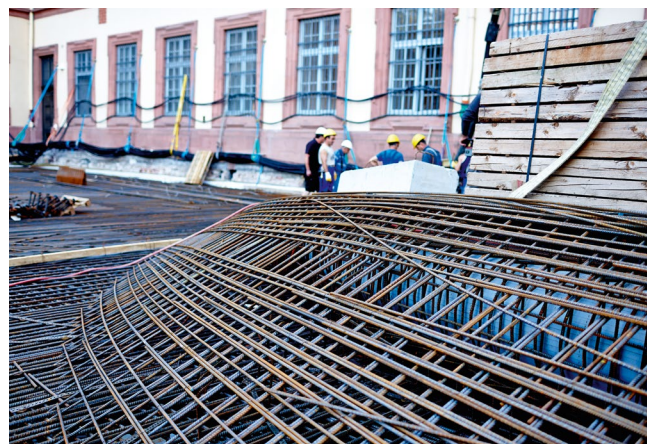
Flachdecke und Kuppelformen wurden mit einer Bewehrung versehen.
