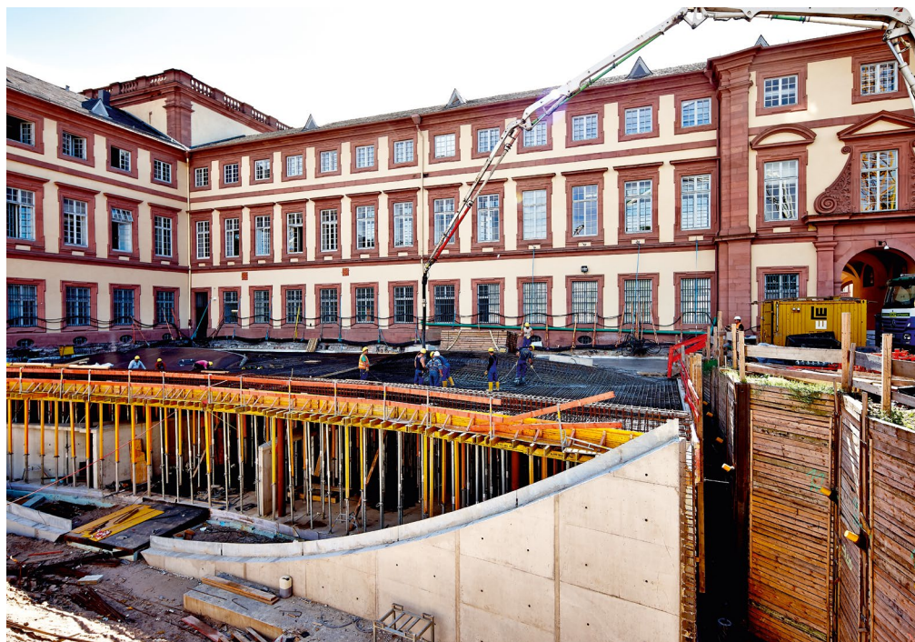
Für die Betonage der Hörsaaldächer kam eine vorgefertigte Schalung zum Einsatz.
