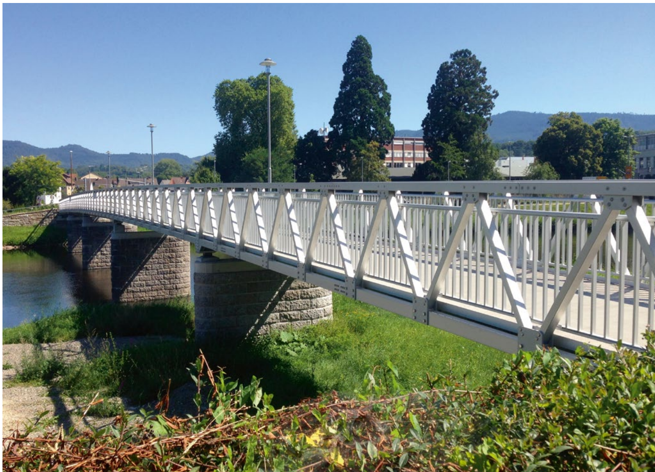
Die Aluminiumkonstruktion des neuen Brückenüberbaus der Schillerbrücke in Gaggenau.
