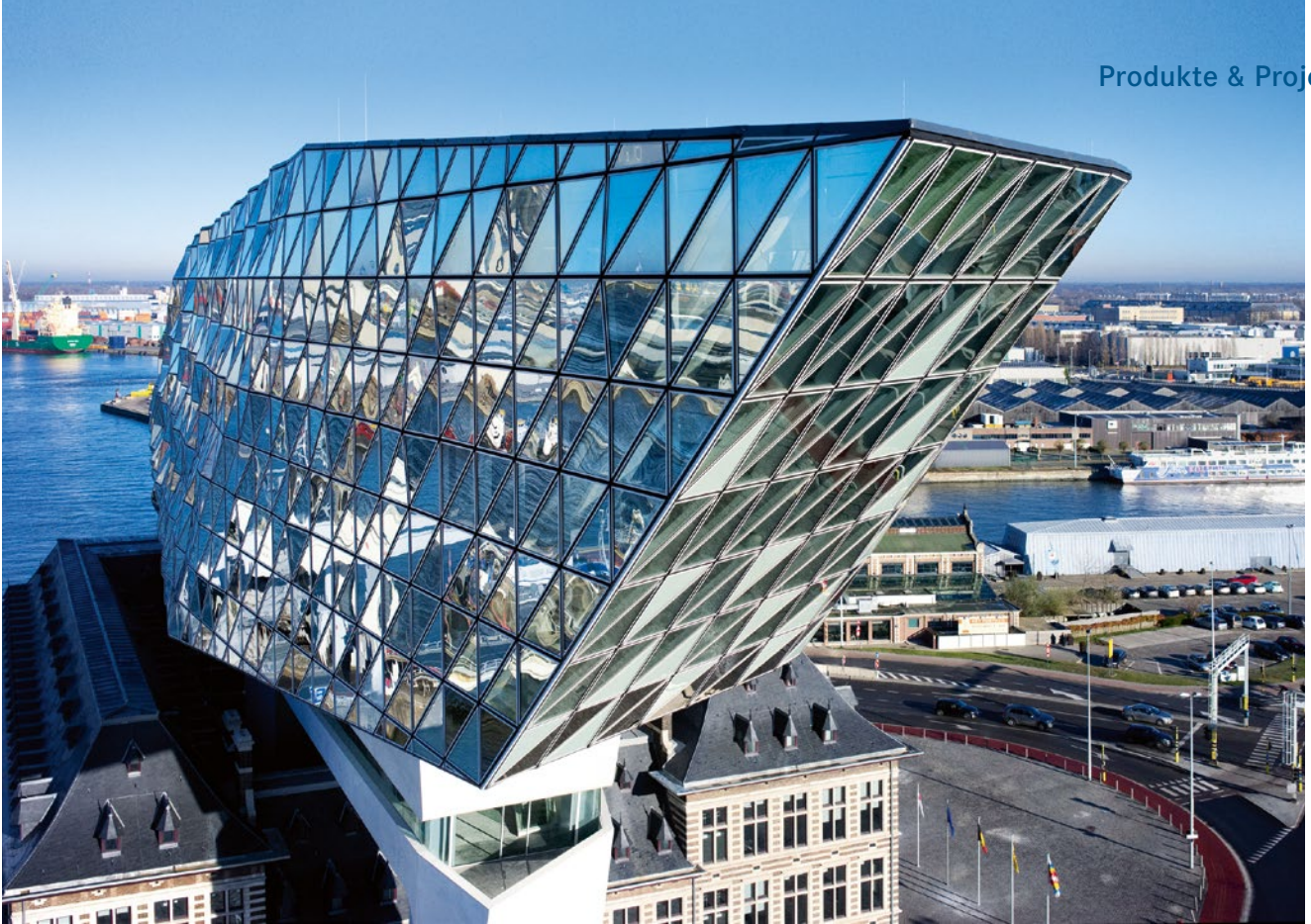
Die speziell entwickelte Sonderkonstruktion der Fassade gibt dem Neubau seine spezifische Form und Oberfläche.
