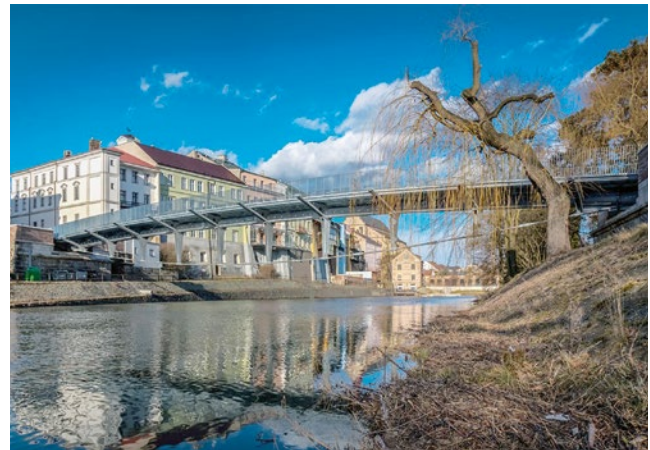
Alle Stahlbauteile der neuen Comeniusbrücke im tschechischen Jaroměř sind feuerverzinkt.
