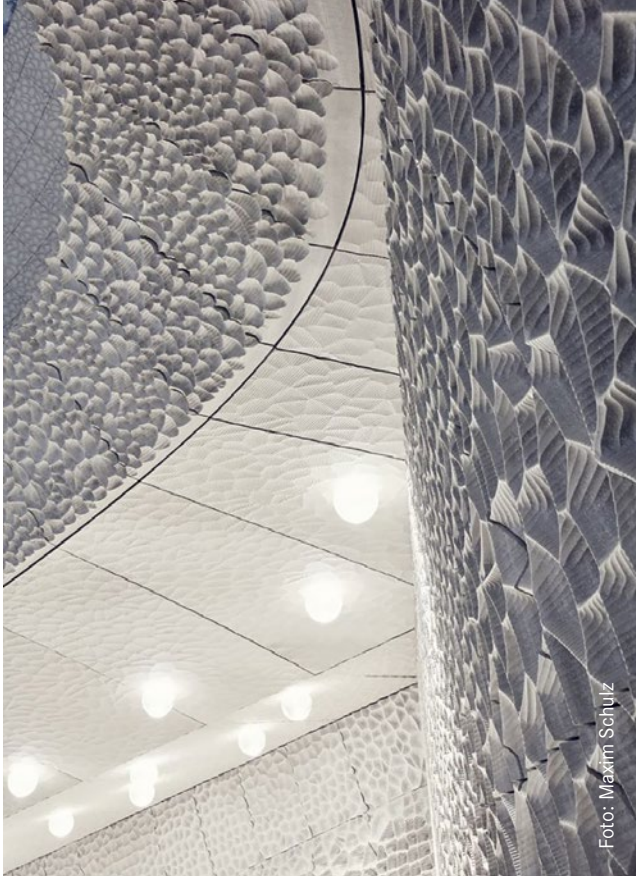
Rund 10.000 individuell gefräste Gipsfaserplatten wurden montiert.
