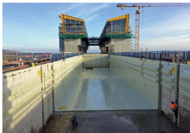
Oberer Vorhafen: Kanalbrücke
